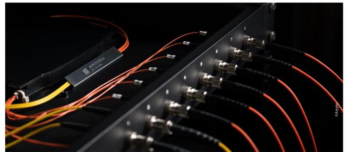
Modulo compatto AROONA-STAR a 2 fibre installato in un armadio di distribuzione esistente, per aumentare la larghezza di banda di una sola coppia di fibre multimodali.
